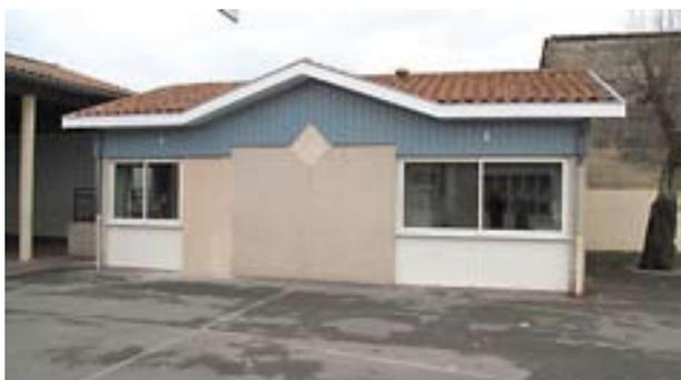
A l'école, les sanitaires extérieurs ont été mis hors-gel par des menuiseries en aluminium avec double vitrage et une isolation des plafonds. La mairie a profité de ces travaux pour créer 2 lavabos côté garçons et 2 lavabos côté filles ainsi qu'un WC supplémentaire qui est adapté aux handicapés. Les WC ont été opérationnels pour la rentrée des classes de septembre 2010. [Financement sans subventions : 22 000€ TTC].
